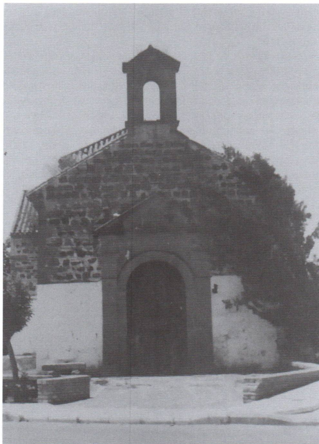
Fachada principal de la ermita antes de su restauración.
