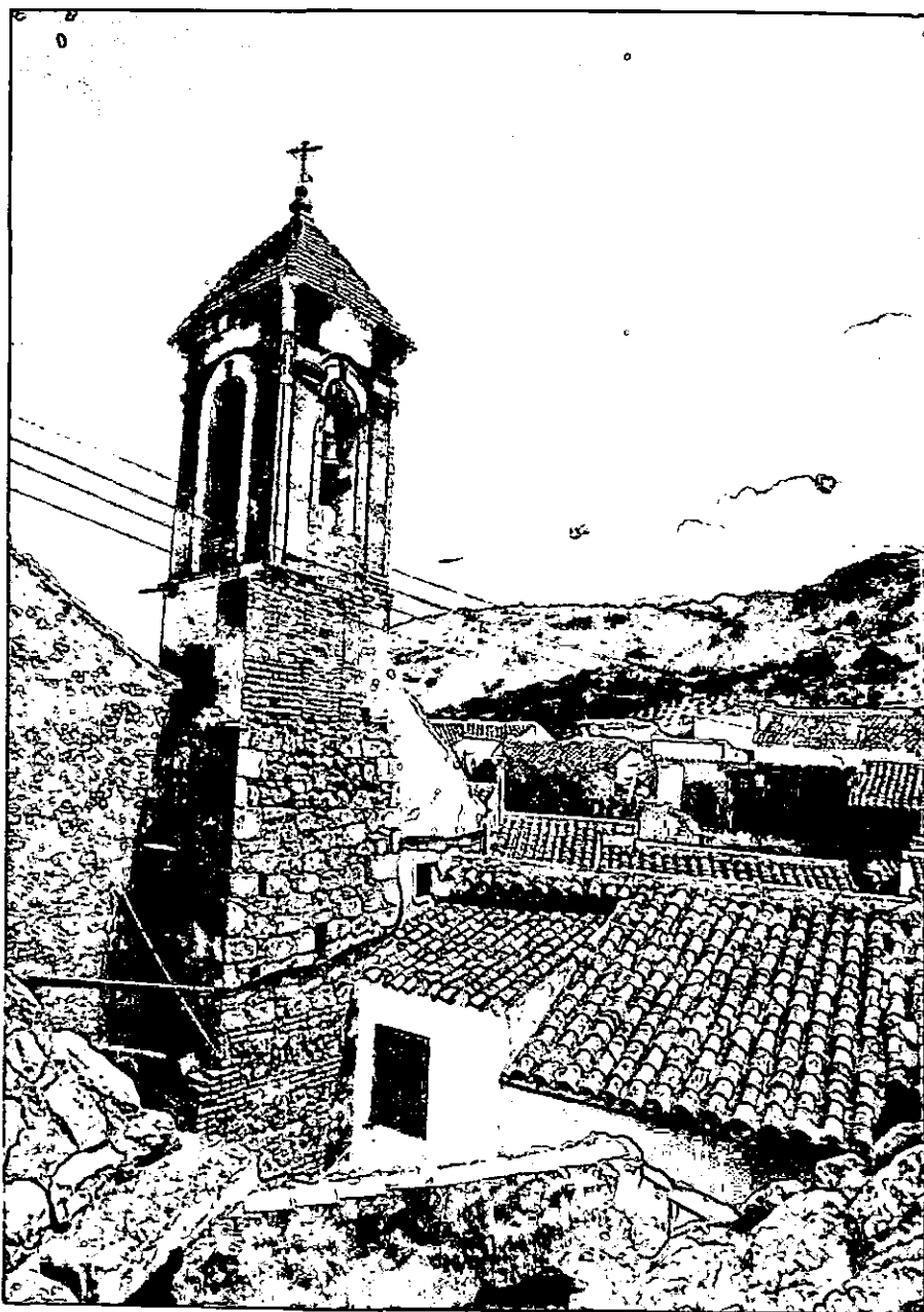
Vista meridional de la Torre campanario y en su base restos del alminar mudéjar .
